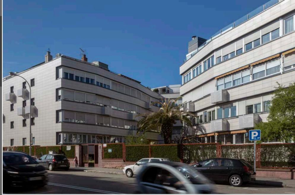
Se trata de un edificio de viviendas y locales de oficinas en la zona norte del barrio de Chamartín en Madrid. Se construyó en 1972, con una superficie de 12.400 m<sup>2</sup> y estructura de hormigón armado. El cerramiento de fachadas de ladrillo visto es de medio pie de espesor con cámara, pero sin aislamiento.
