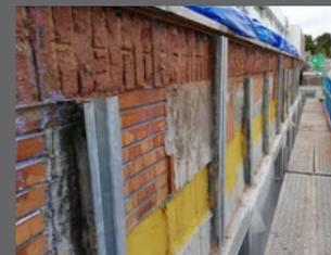
Los ensayos fueron realizados por la empresa de los anclajes. Según los resultados obtenidos de los ensayos para el material base de ladrillo y anclaje mecánico HRD, la Frd es 0,72 kN. Resistencia baja, pero permitió el empleo de anclajes químicos mediante resina HIT-HY 170 para las ménsulas fijadas sobre material de ladrillo.
